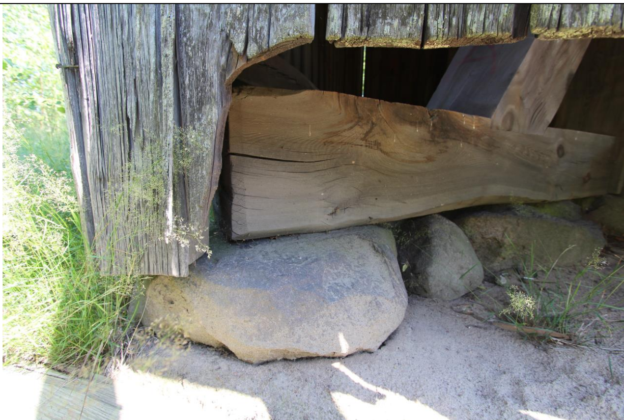
Fot. nr 7 – Posadowienie kozła na kamieniach
