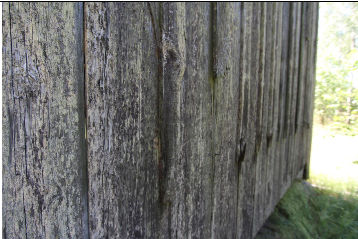
Fot. nr 8- Deskowanie pionowe na elewacjach
